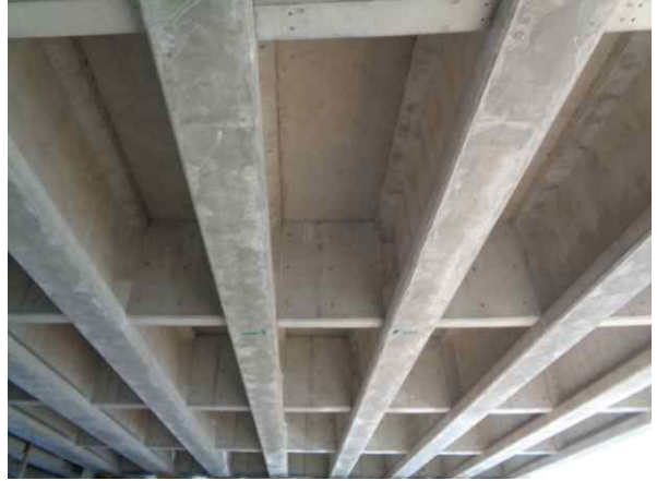
바닥판하면, 거더 전경
