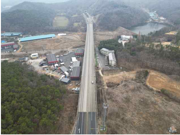
교량 상부 전경
