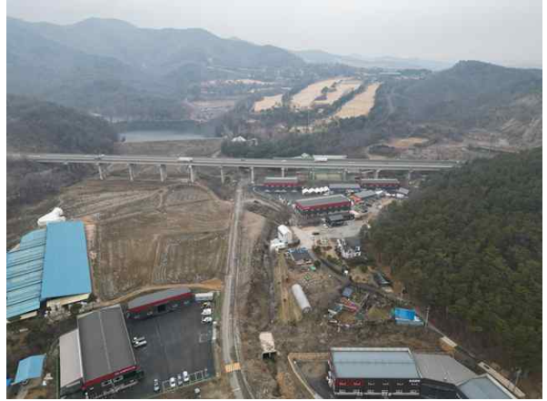
교량 측면 전경
