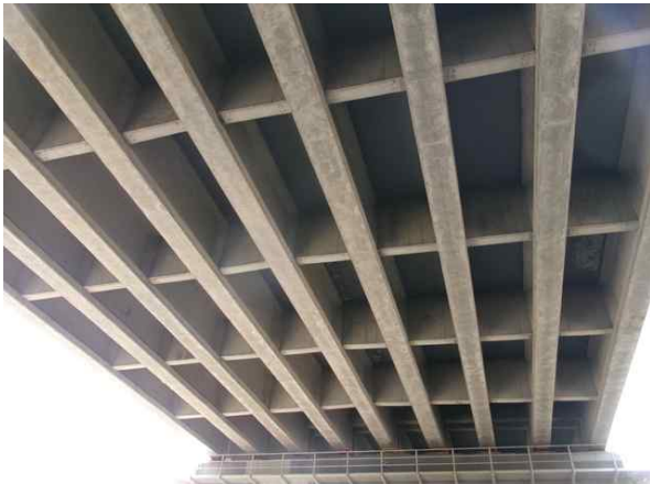
바닥판 하면 및 거더 전경
