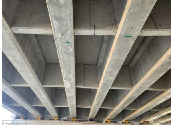
바닥판하면, 거더 전경
